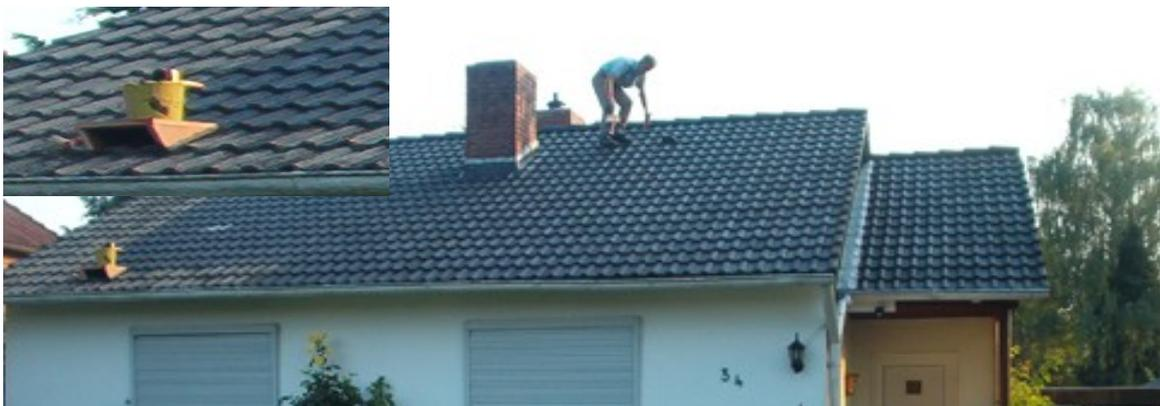
Zum Grundieren darf das Dach feucht aber nicht nass sein, außer bei DUREXON 2810, hier ist Trockenheit gefordert. Die Temperatur darf nicht unter +5°C und nicht über +40°C liegen.
